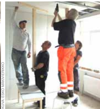
Kipsilevyt kattoon. Vas. Vitali, Esko poraa sähkörasialle Robin oikealla, Bosse ruuvaa reikää kipsilevyseinään. levyn kiinni.
