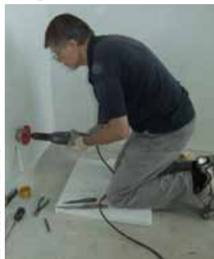
Kipsilevyt kattoon. Vas. Vitali, Esko poraa sähkörasialle Robin oikealla, Bosse ruuvaa reikää kipsilevyseinään. levyn kiinni.
